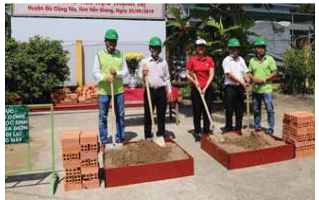
Đại diện Quý Vị cuộc sống tươi đẹp và Chi hội “Xanh Yêu Thương” tiến hành nghi thức khởi công xây dựng nhà vệ sinh và hệ thống lọc nước sạch tại trường Tiểu học Thạch Trị, huyện Gò Công Tây, tỉnh Tiền Giang
